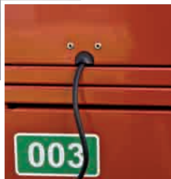
Alternative: Kabeldurchführung mit Gummilippe, sofern der Akku zum Laden am Pedelec/E-Bike verbleiben soll
