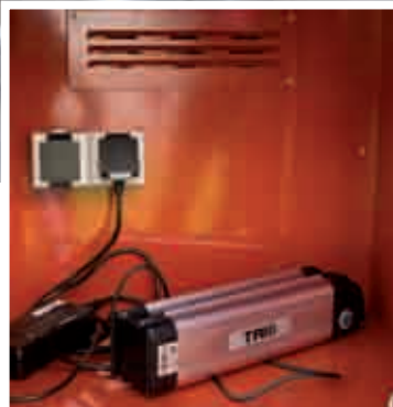
Akkuaufladung in witterungs- und zugriffsgeschütztem Safegehäuse
