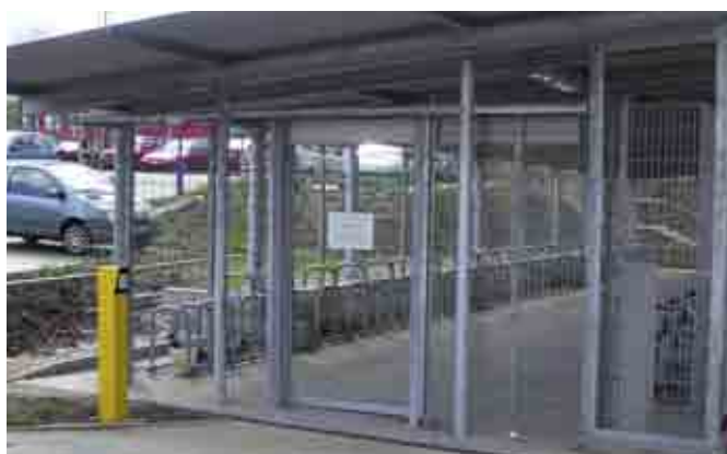
Gesichertes Radparken mit Zugangskontrolle
