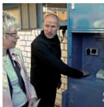
▲ Je Fach 2 Steckdosen, mit FI-Schalter abgesichert
