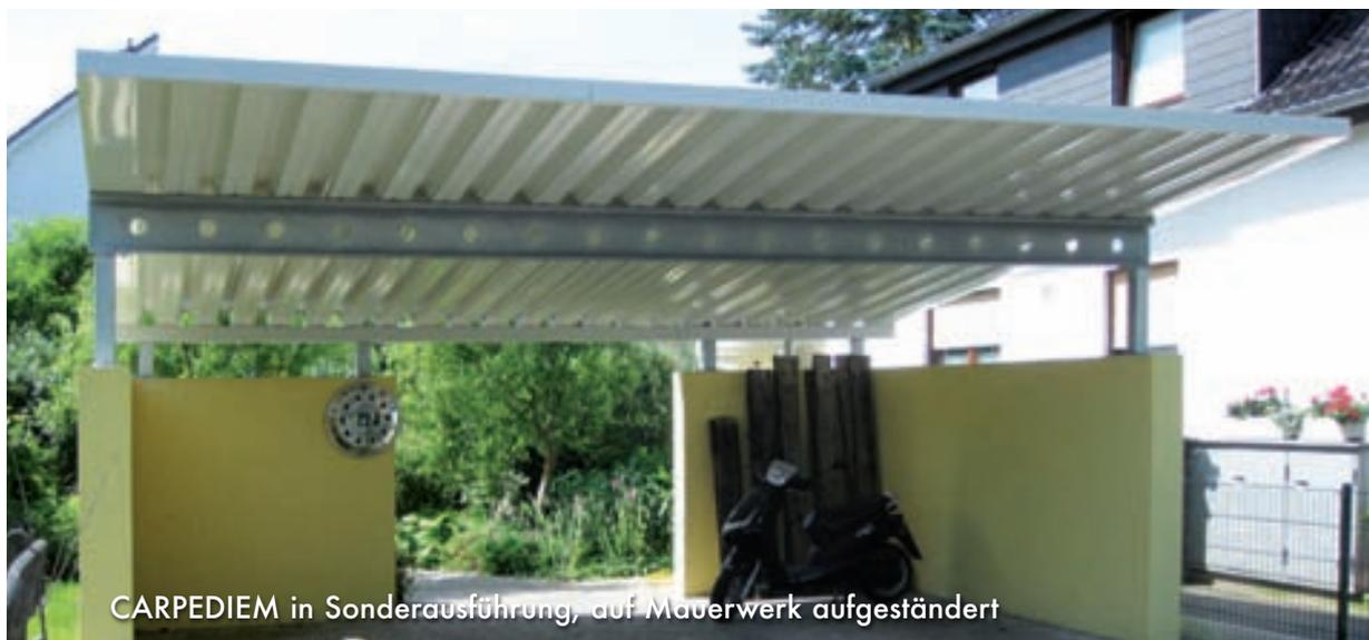
CARPEDIEM in Sonderausführung, auf Mauerwerk aufgeständert
